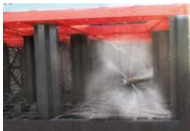
Čištění vsakovací galerie
