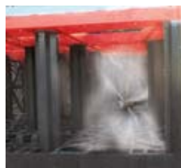
Jednoduchá inspekce a čištění
